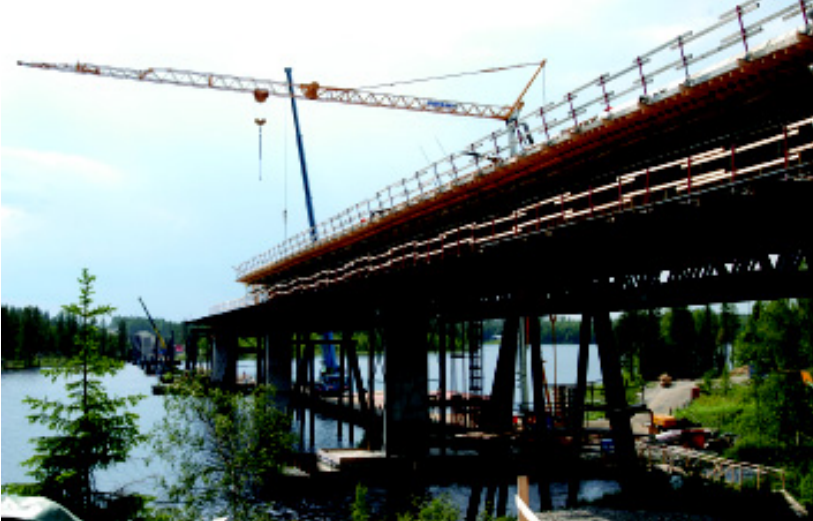
Efterspänd huvudbalk i betong med relativt tunn konsol av betong. Byggt på ställning med fackverksbalkar (Offersjön).
