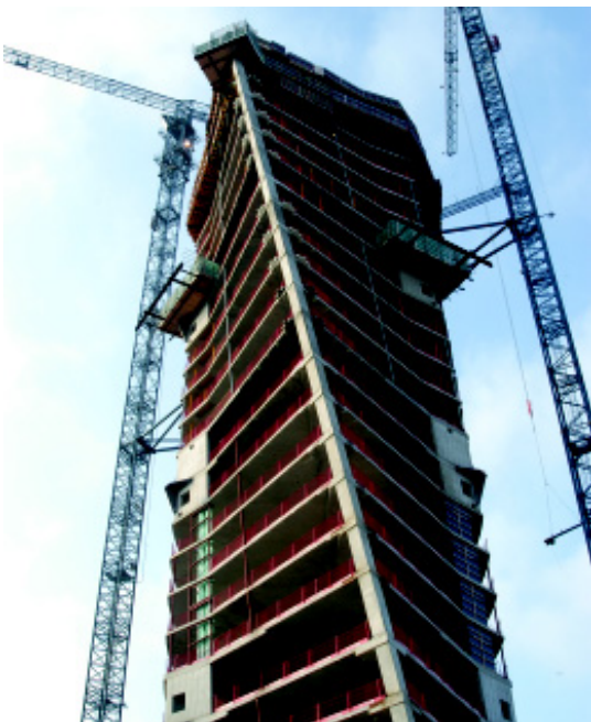
Turning Torso under uppförande.
