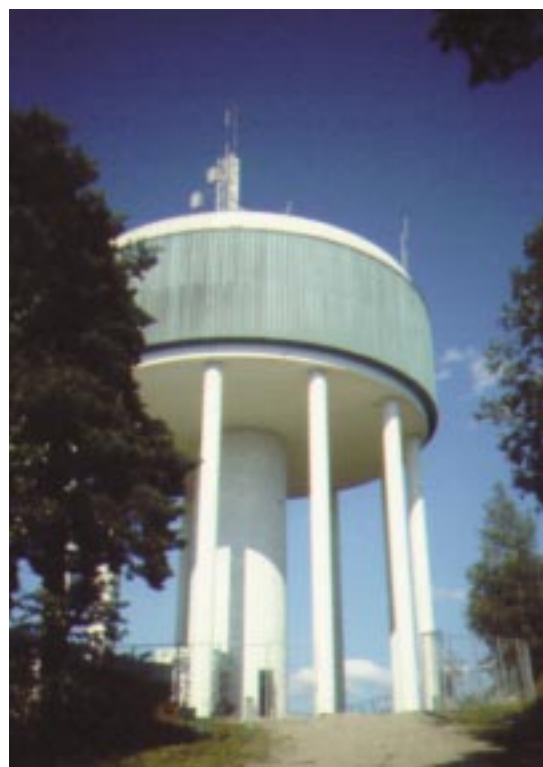
Lyckad lagning på ett vattentorn i Mellansverige.
