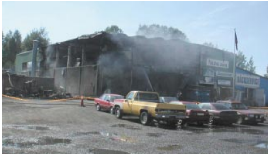
Eftersläckning av brand i industrifastighet.
