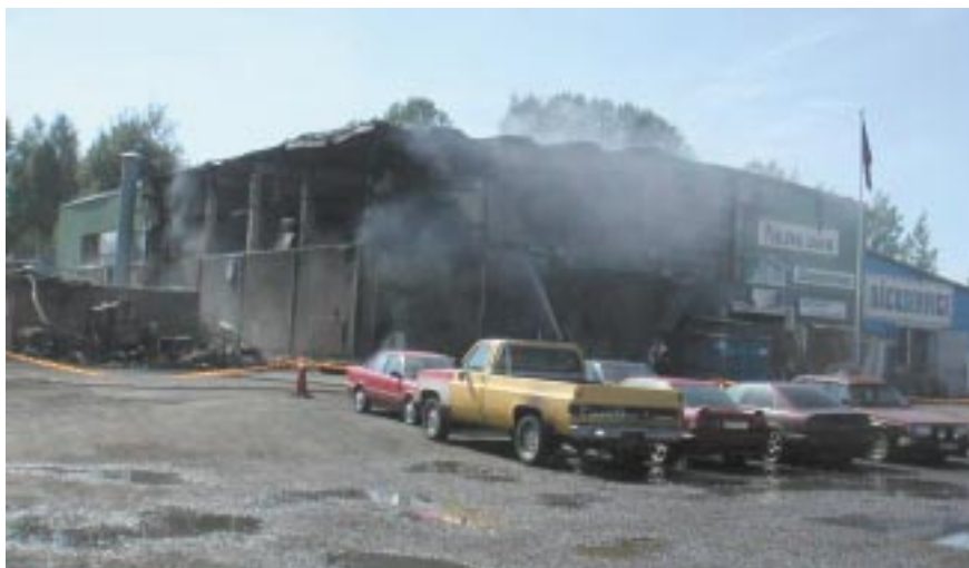
Eftersläckning av brand i industrifastighet.
