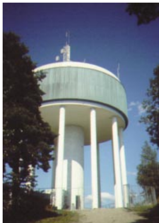
Lyckad lagning på ett vattentorn i Mellansverige.
