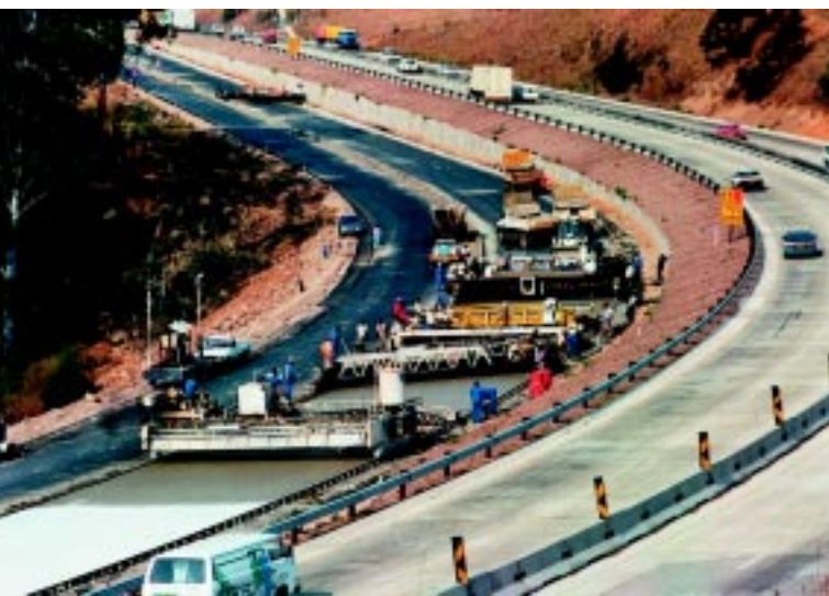
Betongväg utföres med modern betongläggare (tv).
