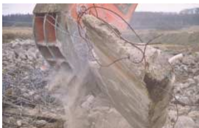
Betongen klipps ner i mindre delar.
