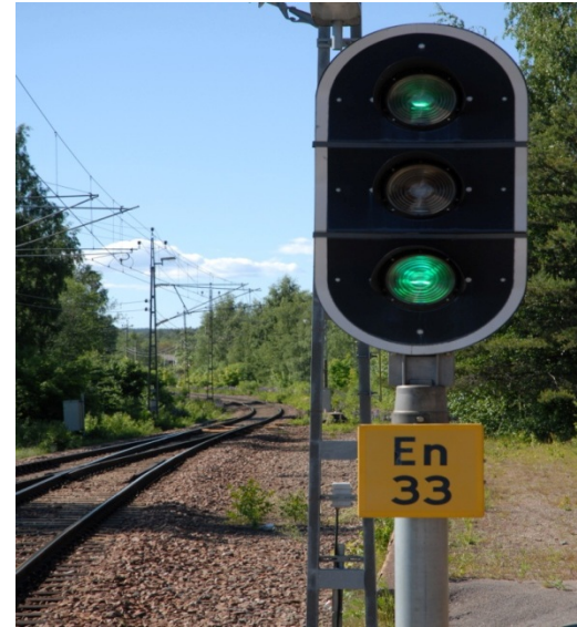
Grön signal Foto: Trafikverket
