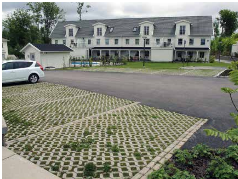
Parkeringsplats av dränerande yta med gallerplattor av betong (t.v).
