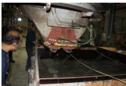
Gjutning av fasadskiva med kolnäs-armering (Strängbetong).
