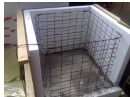
Bild 3. Ett hus under produktion.
