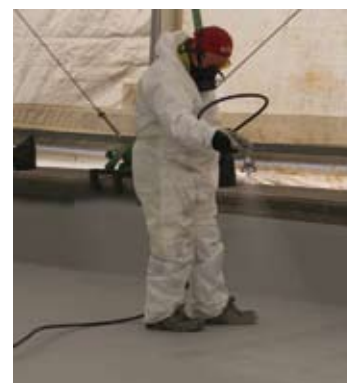
Sprutapplicerat tätskikt med polyuretan.
